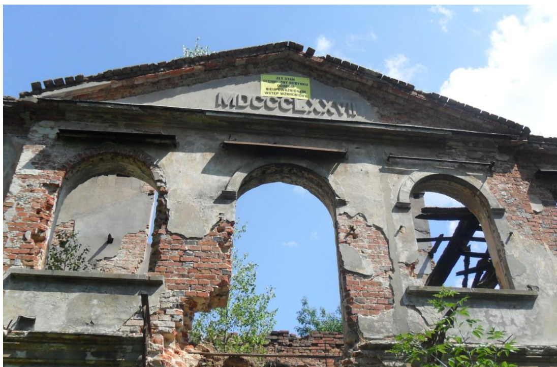
Zachodnia (tylna) ściana dworu;
